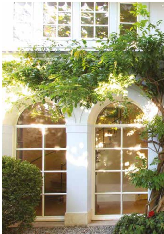
Un menuisier a pu restaurer les fenêtres anciennes, tout en y intégrant un double vitrage. Il en a reproduit de nouvelles, en chêne, à l'identique des modèles construits sous les arches qui dataient probablement du siècle passé.
